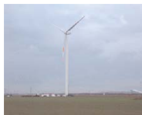
Windpark Nord : 1. Windrad am 14.12.05 aufgebaut. Inzwischen steht der gesamte Park mit 5 Windrädern. Foto: G. Dietrich
